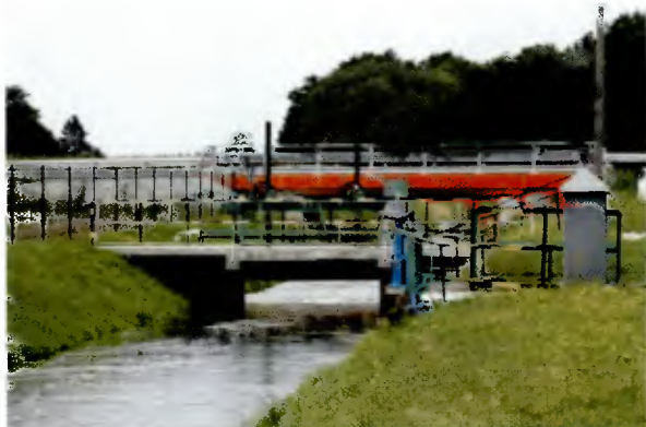
Ujęcie wody powierzchniowej w Krzyżowicach
