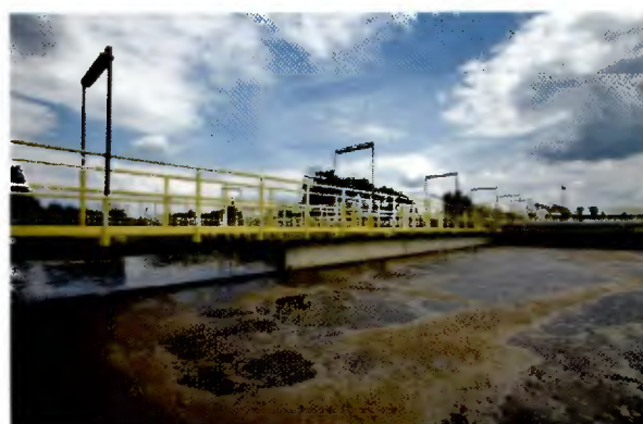
Komory osadu czynnego
